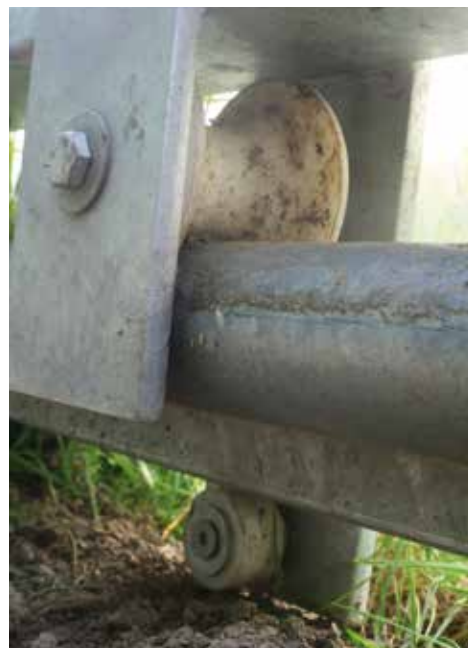
Rolltunnel auf Schienen bewegen sich sehr leichtläufig. Die Gegenrolle verhindert ein Abheben des Tunnels bei Sturm (© Wolfgang Palme, HBLFA Schönbrunn)
