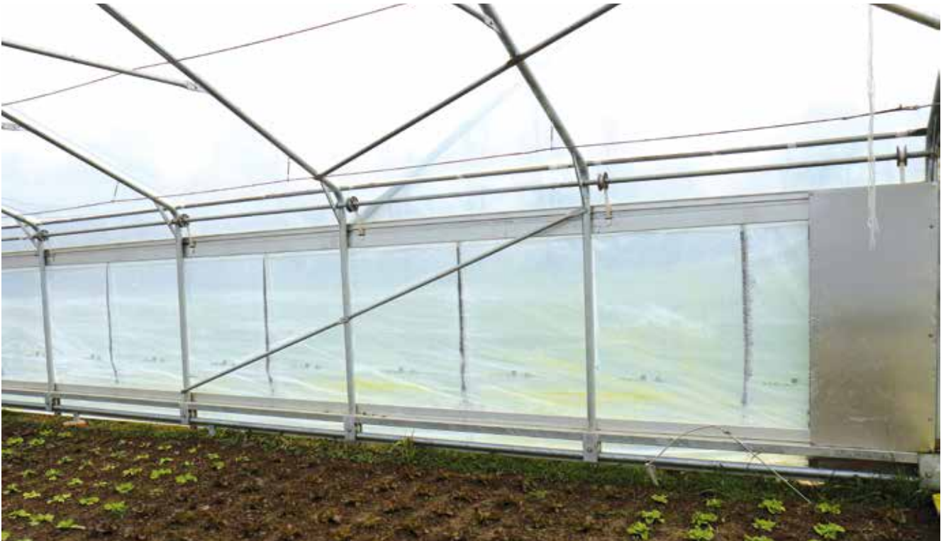
Zusätzliche Quer- und Diagonalverstreben sind bei Rolltunneln nötig. Sie verhindern ein Verwinden beim Ziehen des Tunnels (© Wolfgang Palme, HBLFA Schönbrunn)
